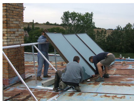
Sestavit rámy k upevnění solárních panelů bylo ze začátku oříškem
